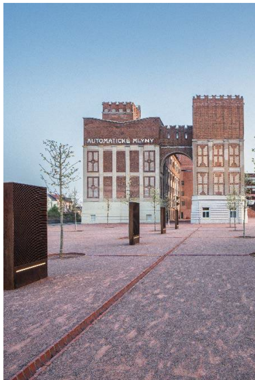
Prokš Přikryl, Winternitz Automatic Mills Grain Silo Conversion, 2018–2023. Photo: Petr Polák
