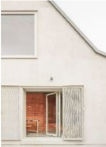
Klöpfel Zeimer Architekten Umbau Siedlerhaus Battin, Battin-Brüssow Foto: Schneepf Renou
