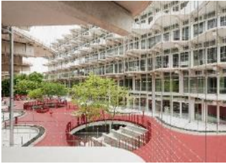
FAR frohn&rojas Wohnungsbau Lion-Feuchtwanger-Straße, Berlin Foto: David Hiepler
