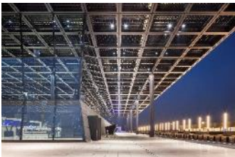
MÄCKLER ARCHITEKTEN Terminal 3 Flughafen Frankfurt Foto: HG Esch
