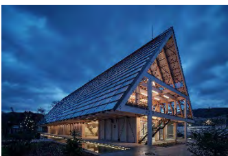
Mjolk, Hauptsitz der Firma Kloboucká lesní, Brumov-Bylnice, 2019–2022. Mjolk, Headquarters of the Kloboucká Lesní Company, Brumov-Bylnice, 2019–2022. Foto Photo: BoysPlayNice
