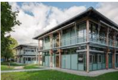
AUER WEBER ASSOZIIERTE Erweiterung Landratsamt Sarnberg Foto: Aldo Amoretti
