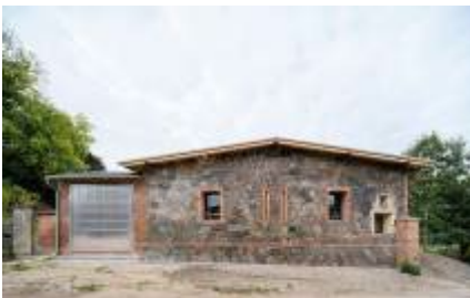
HÜTTEN & PALÄSTE Scheune Prädikow, Umbau, genossenschaftliches Wohn- und Gewerbehäus, Prötzel Foto: Studio Bowie
