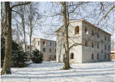
FLORIAN NAGLER ARCHITEKTEN Forschungshäuser Bad Aibling, Bad Aibling Foto: Schels Lanz PK Odessa
