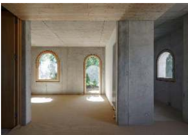
FLORIAN NAGLER ARCHITEKTEN Forschungshäuser Bad Aibling, Bad Aibling Foto: Schels Lanz PK Odessa
