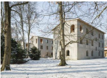
FLORIAN NAGLER ARCHITEKTEN Forschungshäuser Bad Aibling, Bad Aibling Foto: Schels Lanz PK Odessa
