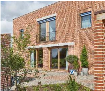
MEIER UNGER ARCHITEKTEN Haus Erler, Fockendorf Foto: Philip Heckhausen
